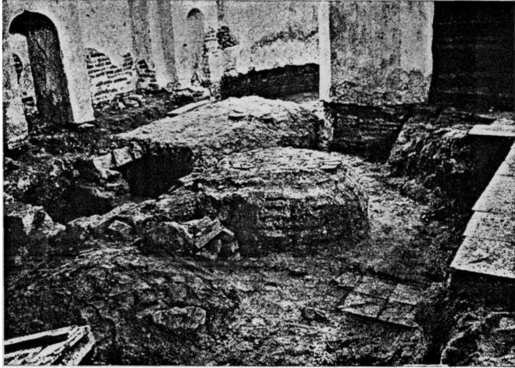
ŚWIĄTYNIA NA KOŁOŻY. DOLNA CZĘŚĆ SŁUPA OKR., KRYPTA I FRAGMENT POSADZKI Z PŁYTEK MAJOLIKOWYCH (1935 R.).
